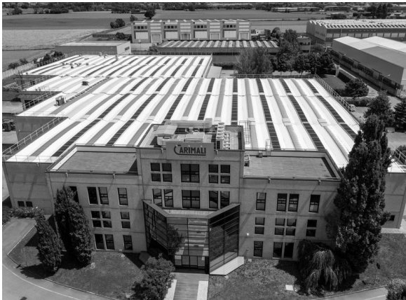
L'impianto fotovoltaico sul tetto dello stabilimento di Chignolo d'Isola (BG).
